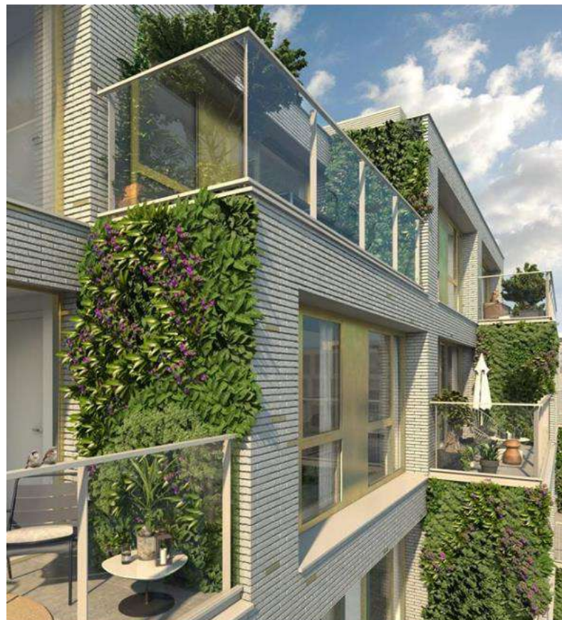
Gebouwde plantenbakken met klimgroen
